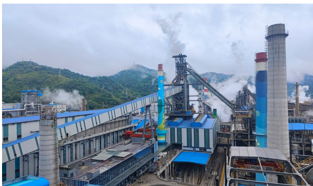
▲ 1号高炉投产全景
