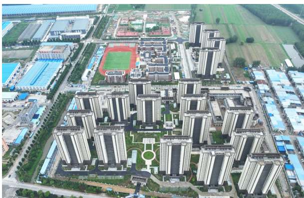
▲ 安置房竣工验收
