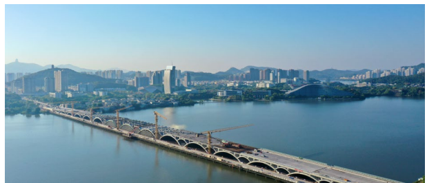
▲ 中国十七冶承建长江黄石段生态环境导向开发 (EOD) 项目磁湖绿色廊道项目主体结构拱圈顺利合龙
