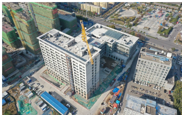
▲ 固镇县中医院工程航拍图
