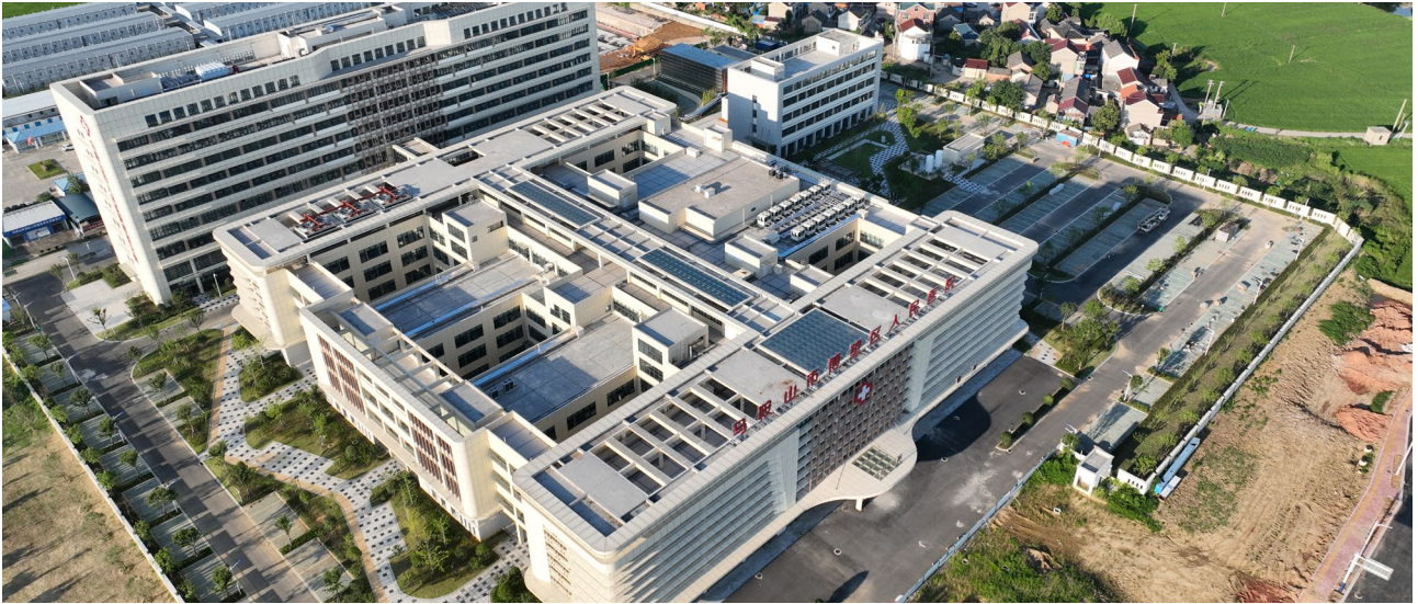
▲ 博望区人民医院项目
