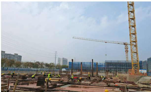
▲ 特教学校项目现场大干，工人正在钢筋绑扎
