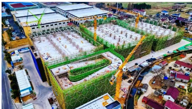
▲ 马鞍山博望智造园、科技孵化园项目
