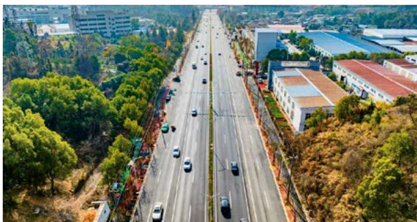
▲ 黄石大泉路生态廊道项目
