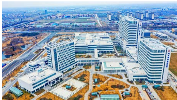
▲ 西安国际港务区新筑悦澜颂 EPC 项目
