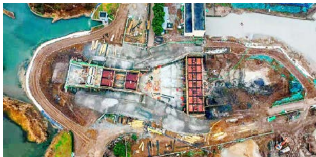
▲ 马鞍山排涝泵站项目
